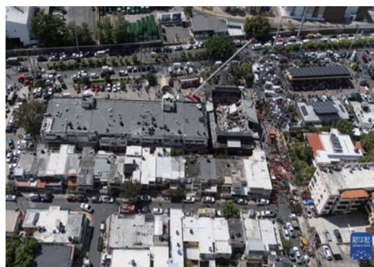
■ 图片来自新华社：这是4月8日在多米尼加首都圣多明各拍摄的夜总会屋顶坍塌事故现场（无人机照片）
