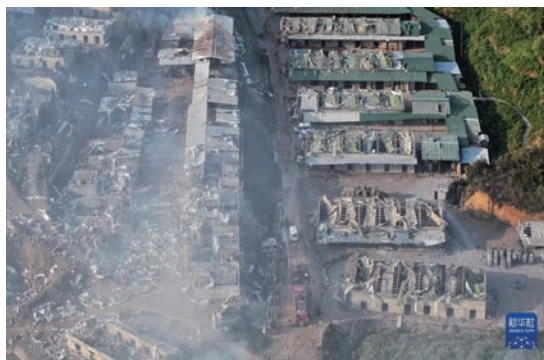
■ 图片来自新华社：6月16日，救援人员在临澧烟花厂爆炸现场工作（无人机照片）
