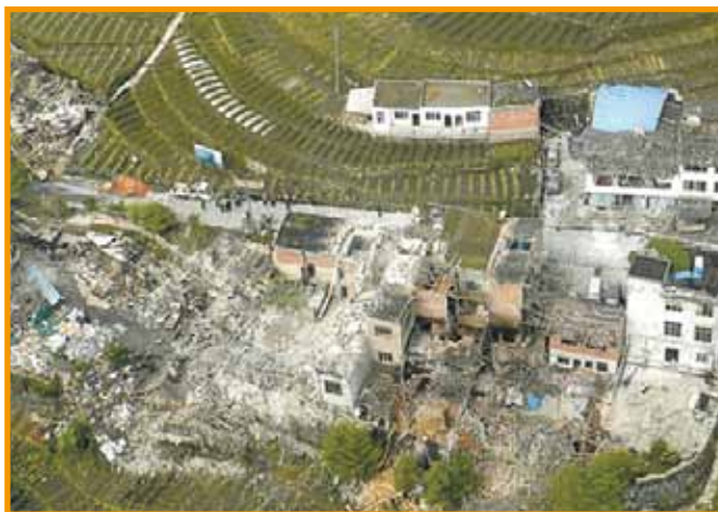
图片来自新华社，这是4月20日在直升机上拍摄的雅安市芦山县太平镇地震灾区倒塌受损的房屋。
